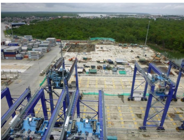
BU: Großbaustelle in Kolumbien: Während der Installation der Schleifleitungssysteme und der E-RTG Modifizierung wurde zeitgleich der Terminal erweitert.
