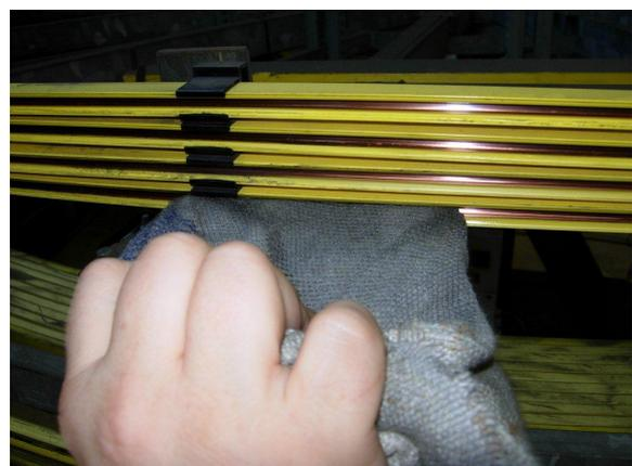
Abbildung 9: Schmutz auch an den Schienenhaltern entfernen
