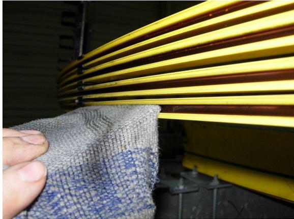
Abbildung 10: Anstellwinkel des Reinigungswerkzeugs ändern, um verschiedene Bereiche zu reinigen
