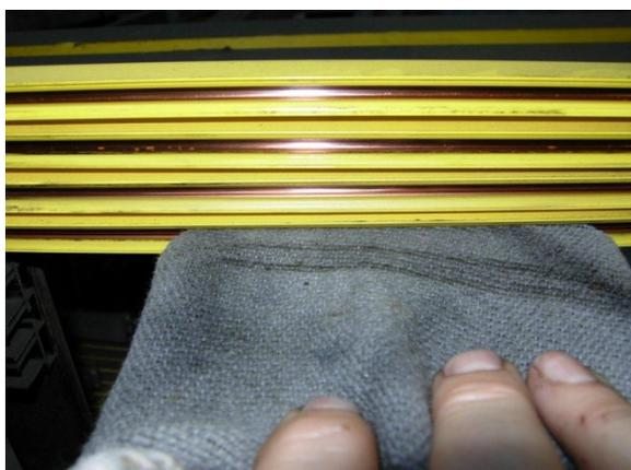
Abbildung 8: Alle Pole der Reihe nach reinigen
