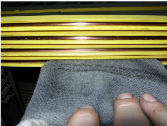
Şekil 8: Tüm kutupları tek tek temizleyin
