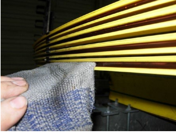
Şekil 10: Farklı bölgeleri temizleyebilmek için temizlik gerecinin açısını değiştirin
