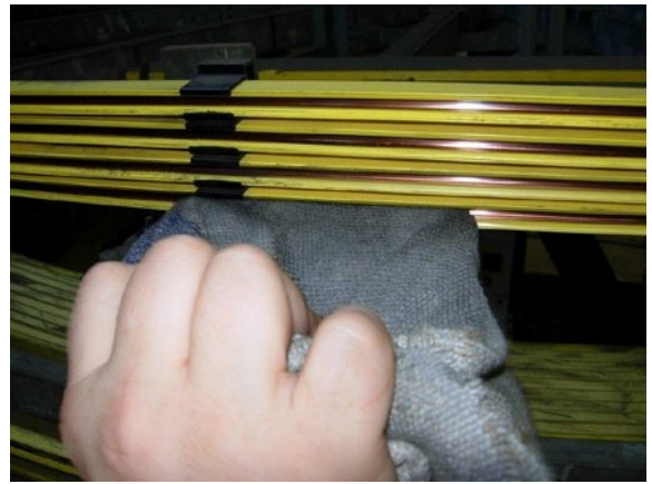
Şekil kelepçe : Ayrıca askı kelepçelerindeki kirleri de temizleyin
